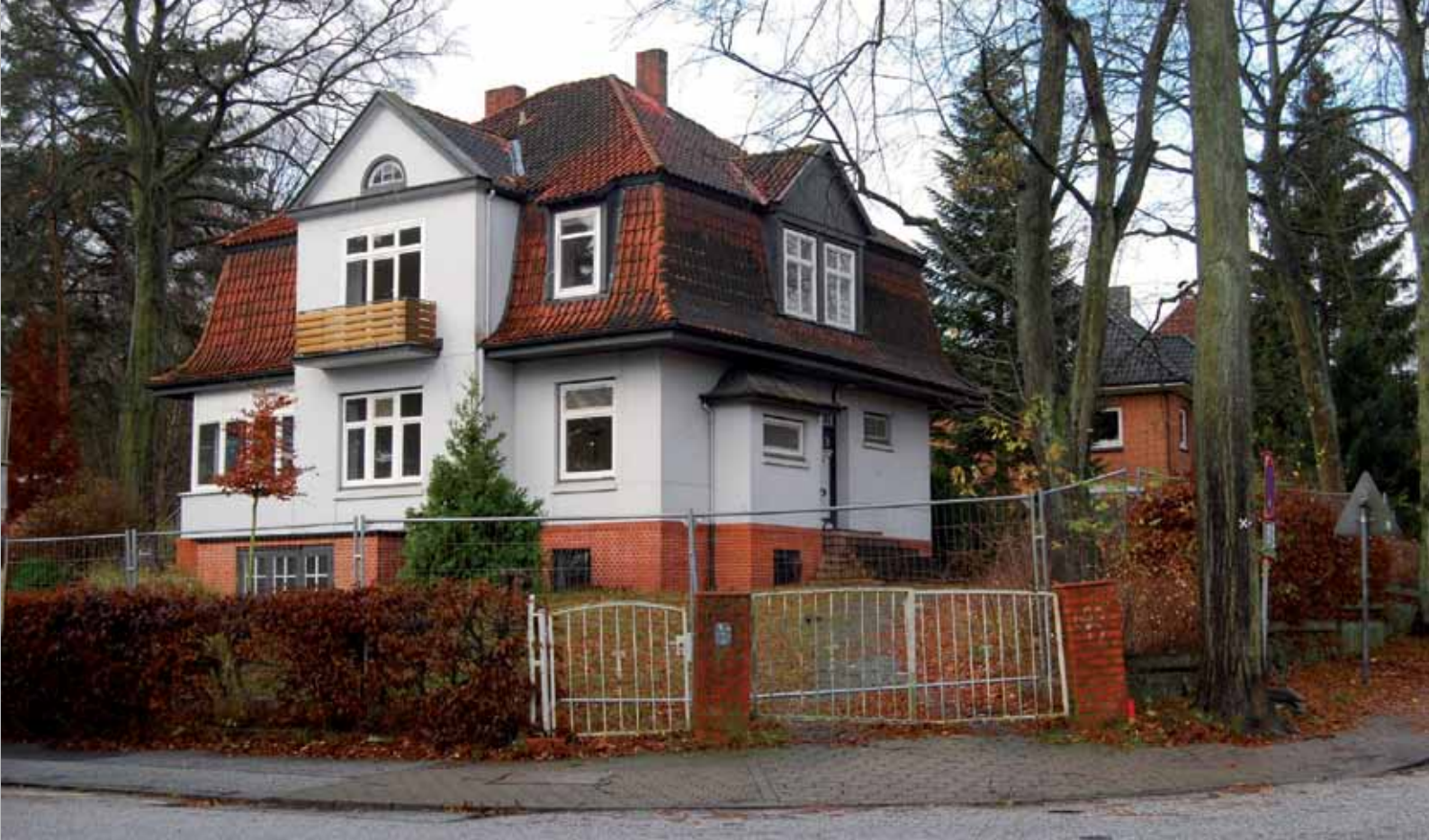
Kurz vor dem Abriss: Die historische Dacheindeckung und der weitgehend originale Zustand fallen auch dem Laien auf. (Foto: Claudius Wenzel)
